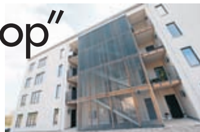
Forskningen inom LWE:s ramar har medfört att Moelven har kunnat utveckla lägenhetsbyggande i modulform. Därutöver kan företaget, tack vare samarbetet med LWE, leverera Trä8, ett nytt byggsystem för höghus i limträ.
